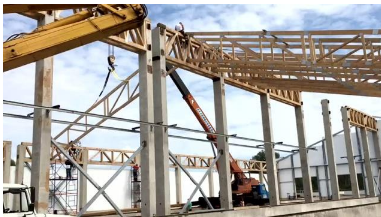
Монтаж перекрытий здания
