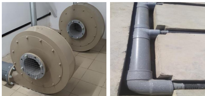
Промышленные воздуходувки и каналы аэрации
